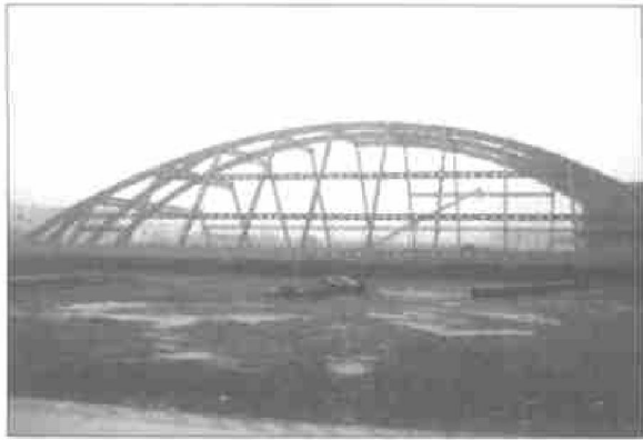
图 7 采用 WJ510C2 钢建成的上海中国残疾人体育艺术培训基地网架
