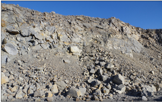
图3 预裂边坡开挖后实际效果
