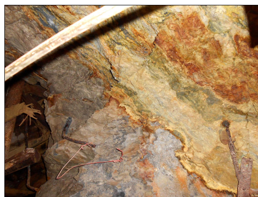
图7 沃溪坑口29平V3号矿脉南(产状: 335° ∠ 31°)
